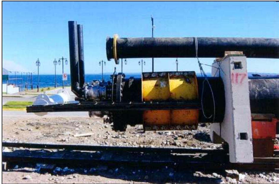
Figura N°2. Tubos “snorkel” usados para vaciar el aire durante el lanzamiento, que se encontraban obturados y casi soterrados en el fondo marino.
